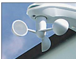
Si un automatisme est prévu, il faut contrôler périodiquement le fonctionnement de l'anémomètre et les éventuels dégâts causés par des influences extérieures (observer le tournoiement lors du vent). Si l'anémomètre ne tourne pas correctement, il faut aviser le storiste agréé STOBAG.
